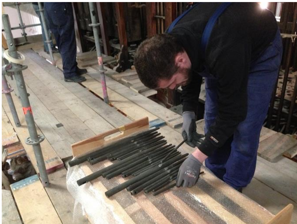
De pijpen die uit het orgel zijn genomen, worden exact op volgorde gelegd in speciale transportkisten, om te worden vervoerd naar de werkplaats van de orgelmaker.
